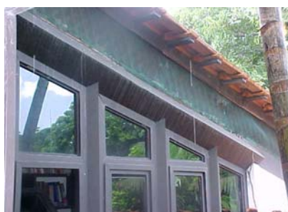
Figura 4 – Cobertura em telhas cerâmicas, ventilada e protegida dos mosquitos típicos da região.
