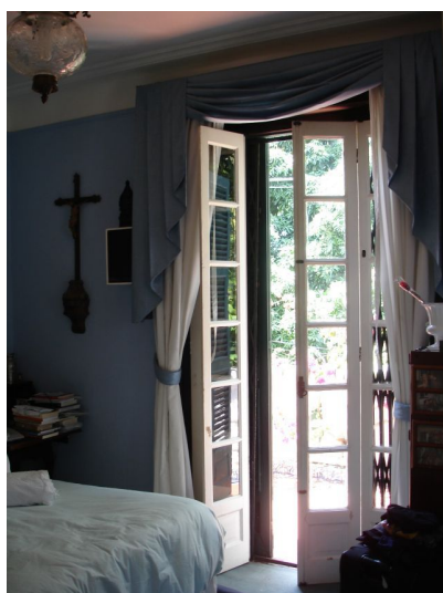
Figuras 11 e 12 – Grandes aberturas proporcionando grandes vãos para ventilação e iluminação e detalhes do beiral e veneziana na varanda do 2 o pavimento
