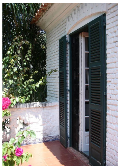
Figuras 11 e 12 – Grandes aberturas proporcionando grandes vãos para ventilação e iluminação e detalhes do beiral e veneziana na varanda do 2 o pavimento
