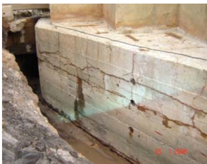
Figura 1 – Bloco escavado, com retirada de testemunhos, apresentando trincas e fissuras após lavagem.
