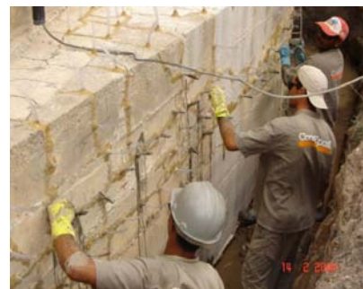
Figura 3 – injeção de microcimento nas trincas e fissuras, pelas mangueiras.
