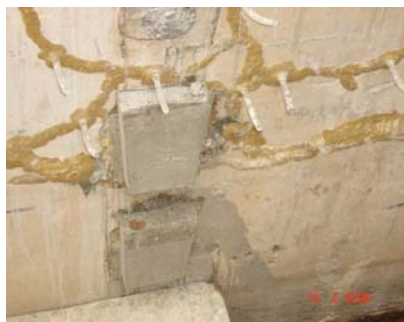
Figura 2 – Vedação das aberturas para extrações de testemunhos, trincas, fissuras e colocação das mangueiras.
