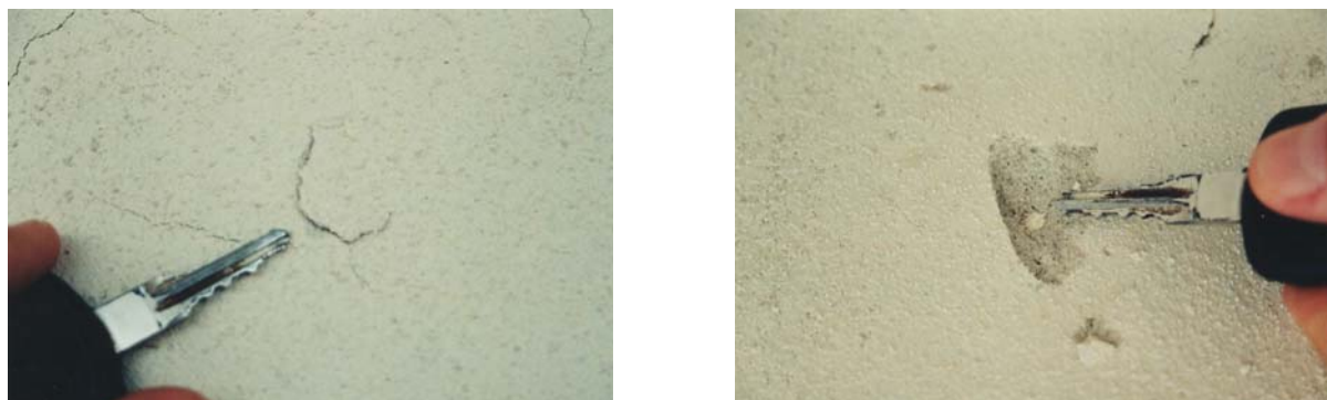
Figura 2 – Aspecto da expansão ocorrida em revestimento de argamassa devido à expansão decorrente da hidratação da cal virgem remanescente na parede, após a aplicação.
