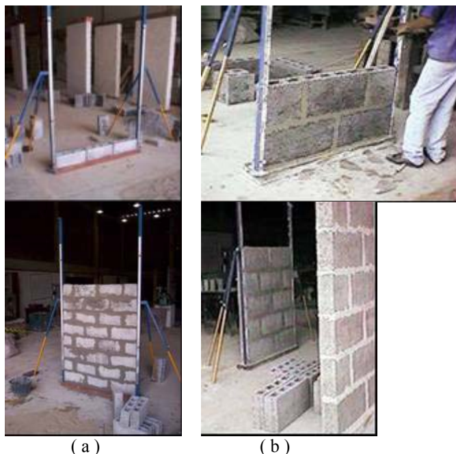
Figura 2 - Detalhe da execução do painel com bloco EVA1 e painel com bloco EVANG, ambos com utilização de escantilhão.
