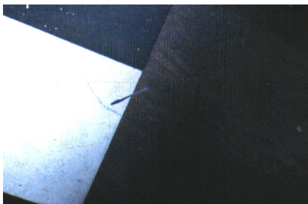
Figura 2 – Trinca na borda do ladrilho, cuja causa mais provável é a espessura insuficiente.
