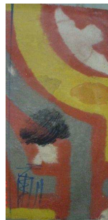
Figura 3 – Ladrilho sem impermeabilização após lavagem com água clorada
