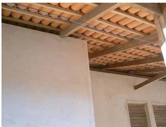
Figura 7 - Vista interna da estrutura de cobertura em madeira e telhamento cerâmico apoiados diretamente sobre a parede de adobe
