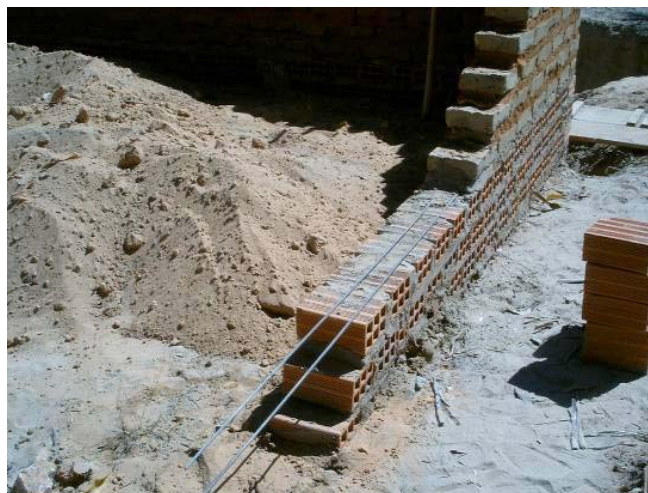
Figura 1 - Barra de aço para estribo com 5mm de diâmetro colocado na argamassa de assentamento do adobe
