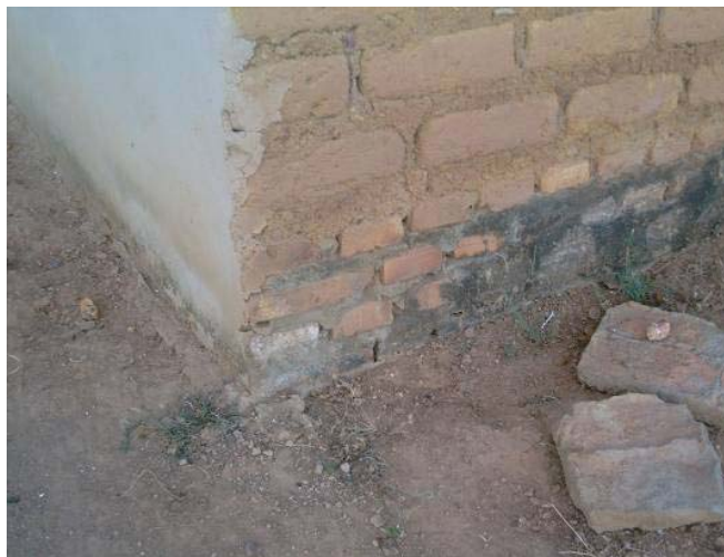
Figura 4 - Detalhe do baldrame em tijolo maciço e parede em adobe
