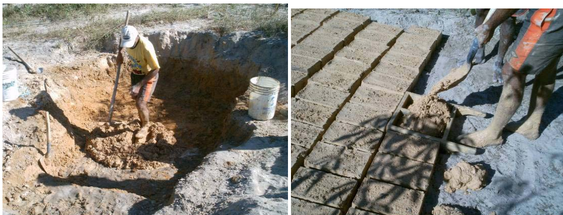
Figura 2 - Barreiro onde é retirado e amassado o solo misturado à água e, em seguida, moldado ao sol
