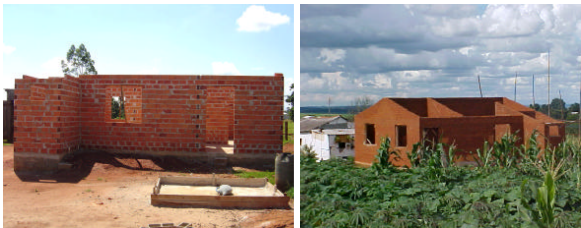
Figura 1 – Sistema de vedação e estrutural em tijolo cerâmico alveolar (habitação 1) e sistema estrutural e de vedação em adobe (habitação 2). Fonte: Grupo de Pesquisa HABIS/EESC USP – UFSCar-2005.
