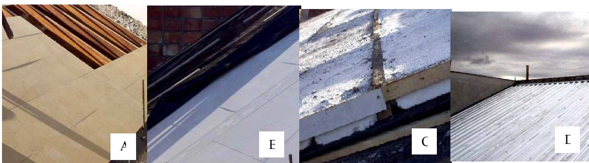
Gráfico 7: aislación térmica de techo, A) ciellorraso de MDF sobre correas de madera; B) colocación de barrera de vapor; C) vista de alfajías de madera, aislación térmica de poliestireno expandido y relleno con hormigón alivianado; D) vista del techo terminado de chapa.
