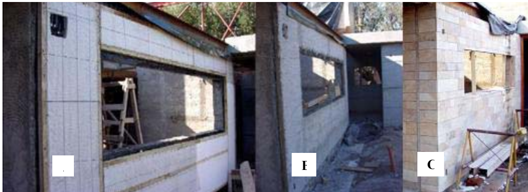
Gráfico 8: incorporación de aislamiento térmico en muros: A) colocación de la barrera de vapor, alfajías de madera, poliestireno expandido entre ellas y metal desplegado; B) agregado de revoque de concreto; C) pegado de terminación en laja de piedra rosa de San Rafael.
