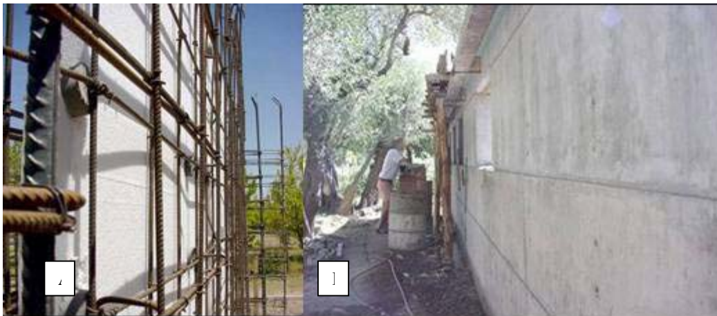
Gráfico 9: incorporación de aislamiento térmico en tabiques de hormigón: A) colocación de armadura doble de cada lado del poliestireno expandido de alta densidad ; B) Desencofrado del tabique llenado por partes, cada una de ellas se divide por las buñas indicadas en la foto.
