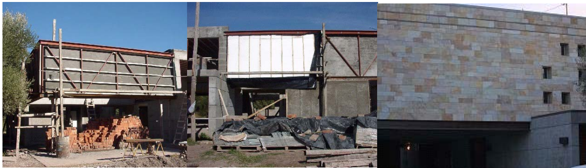
Grafico 10: colocación de aislación térmica en tabiques livianos, A) colocación de alfajías horizontales; B) colocación de poliestireno expandido entre alfajías verticales; C) revestimiento
