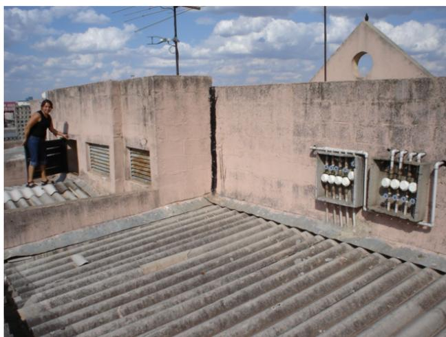
**Figura 4 – Hidrômetros localizados na cobertura do Edifício I.**
