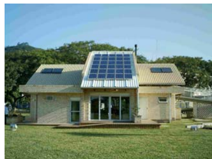
Figura 14. Placas fotovoltaicas (cobertura central) e placas de aquecimento (coberturas laterais).
