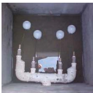
Figura 15. Sistema de descarte de água pluvial. (vista do reservatório).
