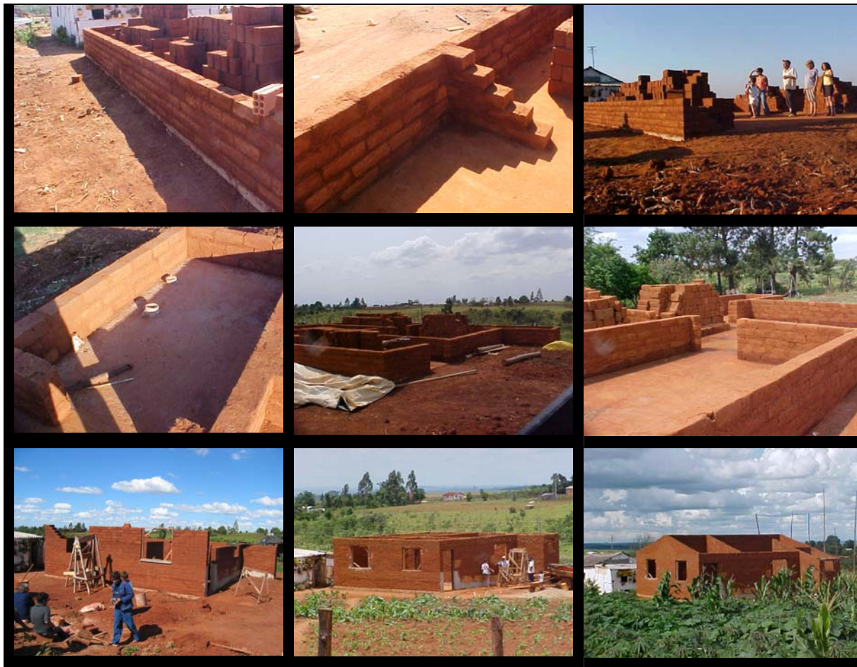
FIGURA 4 - FOTOS DA SEQÜÊNCIA DE ELEVAÇÃO DAS PAREDES EM ADOBE. CONSTRUÍDA (FONTE: GRUPO DE PESQUISA HABIS, 2004)
