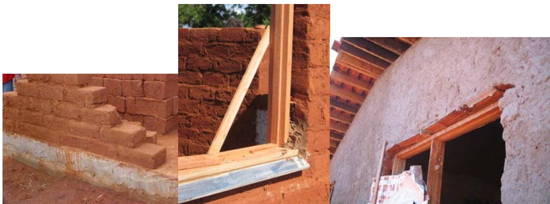
FIGURA 5 – ENCONTRO ENTRE O ADOBE E AS FUNDAÇÕES / INTERFACE ESQUADRIA E PAREDE DE ADOBE / MONTANTE CENTRAL DA ESQUADRIA INSTALADO PARA MINIMIZAR O PROBLEMA DA FLECHA. (FONTE: GRUPO DE PESQUISA HABIS, 2004 E 2005)
