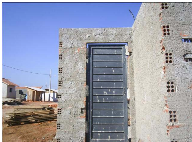
Figura 5- Folga demasiada entre esquadria e alvenaria
