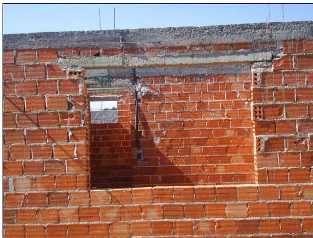
Figura 3 – Existência de bloco cerâmico entre verga e cinta
