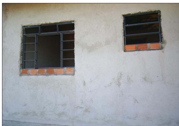
Figura 4 – Preenchimento com blocos cerâmicos após instalação de esquadrias
