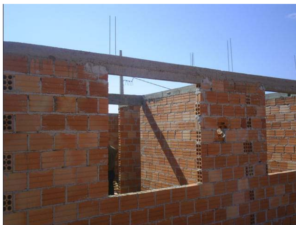
Figura 2 – Verga e cinta sem espaçamento entre as peças
