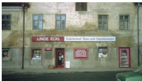
Figs. 1 e 2 – Danos causados por umidade ascendente em edificações de interesse histórico.
