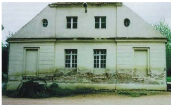
Figs. 1 e 2 – Danos causados por umidade ascendente em edificações de interesse histórico.
