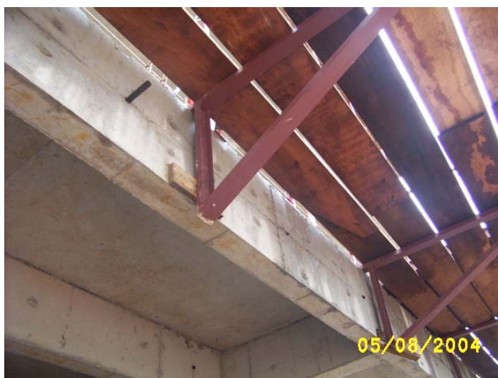
Figura 1: Detalhe inferior da bandeja em madeira, apoios metálicos e fixação das plataformas.
