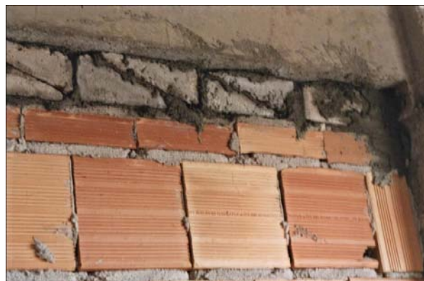
Figura 7 – Travamento da alvenaria com cunhas pré-moldadas de concreto simples aplicadas com a mesma argamassa de assentamento (SAHB, 2005).
