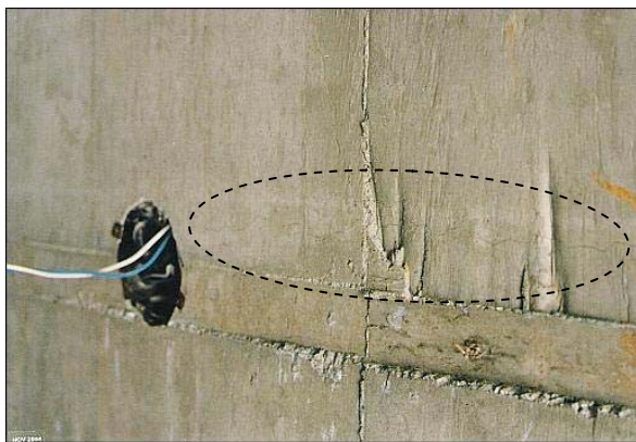
Figura 9 – Fissura devida à flecha excessiva numa laje maciça plana de um pavimento tipo do edifício (SAHB, 2005).
