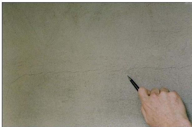
Figura 10 – Fissura na interface viga-alvenaria numa parede revestida causada pela flecha excessiva da viga de apoio (SAHB, 2005).
