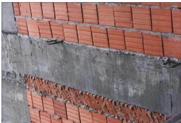
Figura 6 – Travamento da alvenaria por meio de tijolos maciços cerâmicos assentes inclinados com argamassa de assentamento (SAHB, 2005).
