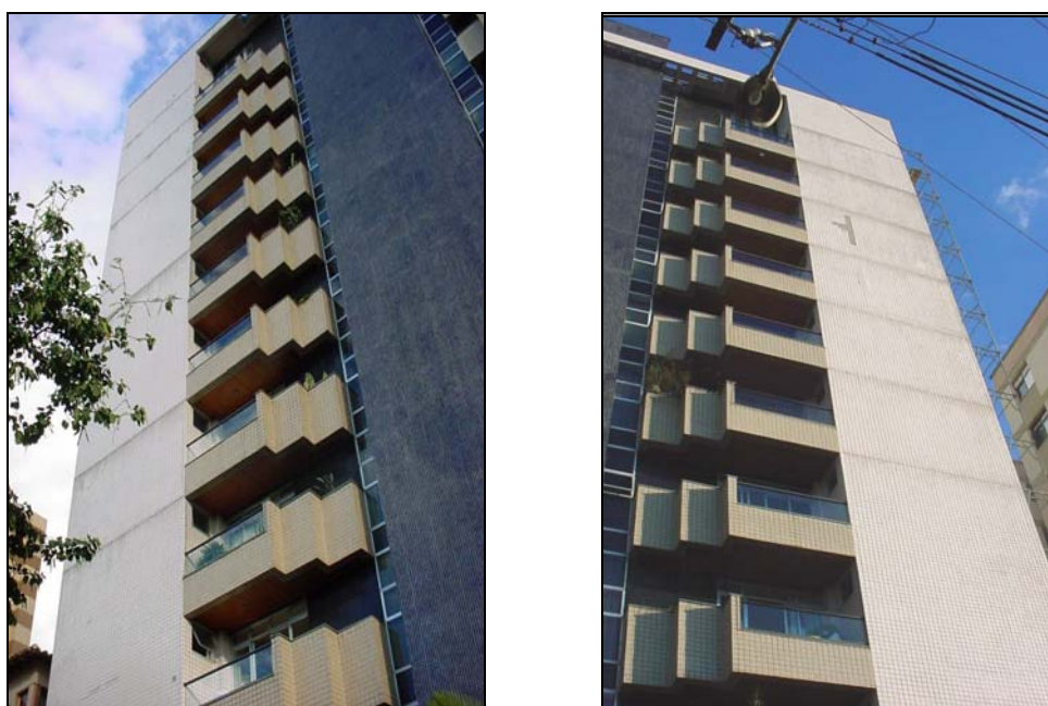
Figura 2.5 – Edifício residencial. Fachada comprometida por manchamento do selante
