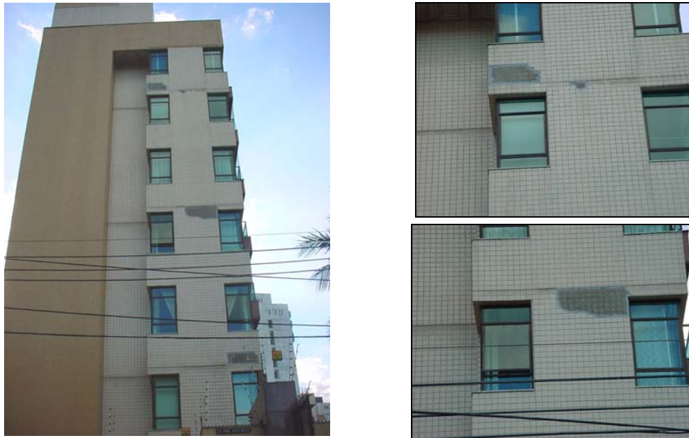
Figura 2.8 - Edifício residencial. Fachada com destacamento iniciando na região da junta de movimentação
