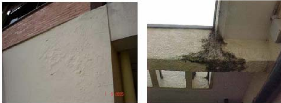
Figura 6 e 7 Bolhas e manchas na pintura efeito de umidade (Foto Viviane Matos, 2005)
