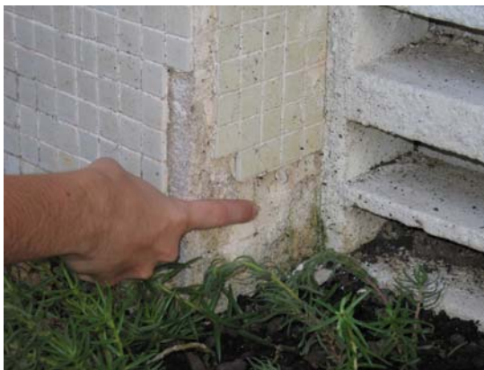
Figura 8 Descolamento do acabamento por efeito de umidade por microcapilaridade (Foto Viviane Matos, 2005)
