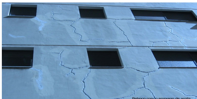
Figura 3 – Fissura no revestimento externo.
