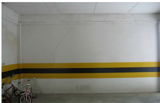
Figura 11 – Fissura em alvenaria no pavimento garagem.
