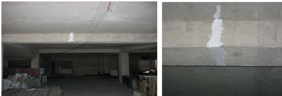
Figura 12a – Fissura em viga de garagem e 12b: a fissura em detalhe.
