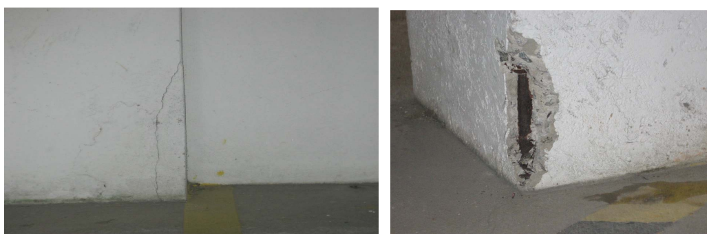
Figura 8a e 8b – Fissuras no pilar próximo ao piso no pavimento garagem.
