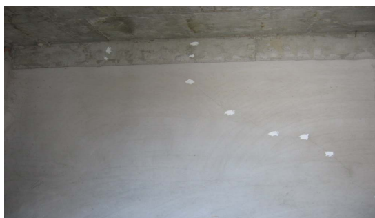
Figura 14 – Fissura em alvenaria no pavimento tipo.
