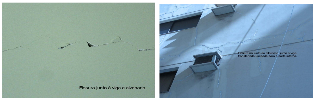
Figura 1 – Fissura na parte interna da edificação junto à viga (1º andar); Figura 2 – Fissura na parte externa da edificação na junta de dilatação (1º andar).
