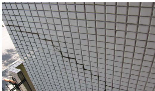
Figura 5a– Fissura na alvenaria do 1º andar apoiada sobre viga em balanço e 5b: Fissura em detalhe.
