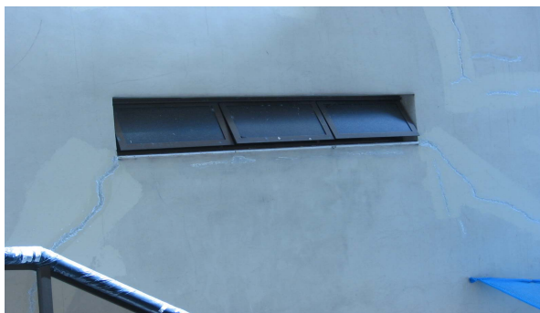
Figura 4 – Fissura junto à janela no andar térreo.
