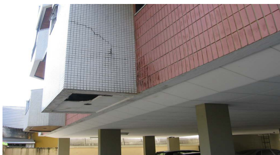
Figura 5a– Fissura na alvenaria do 1º andar apoiada sobre viga em balanço e 5b: Fissura em detalhe.
