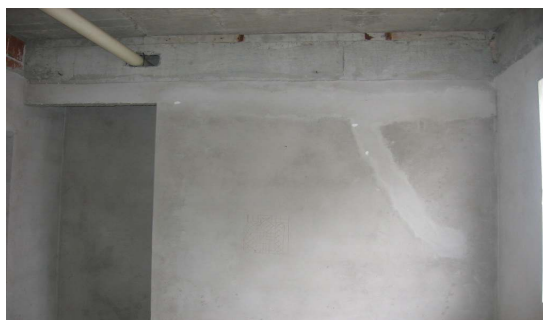
Figura 15 – Fissura em alvenaria no pavimento tipo.
