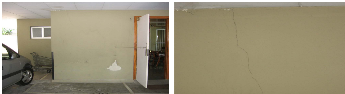
Figura 6a – Fissura na alvenaria do andar térreo junto ao pilar e 6b a fissura em detalhe.
