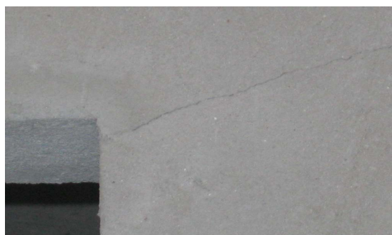
Figura 16 – Fissura no canto de vão de porta no pavimento tipo.
