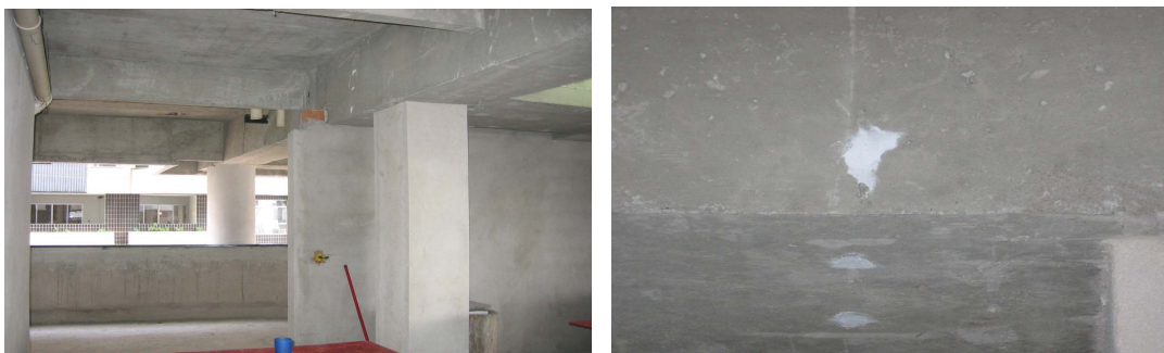
Figura 13a – Fissura em viga de transição do pilotis 13b: a fissura em detalhe.
