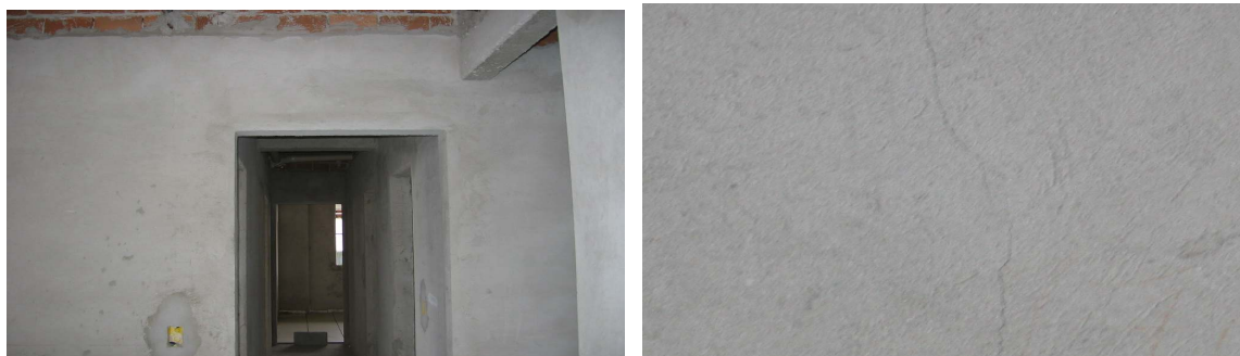
Figura 17a – Fissura na alvenaria do pavimento tipo e 17b: a fissura em detalhe.
