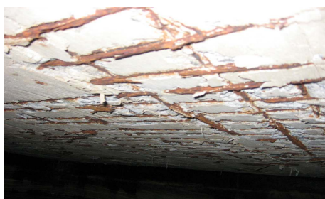
Figura 7 – Fissura no teto do reservatório de água potável.
