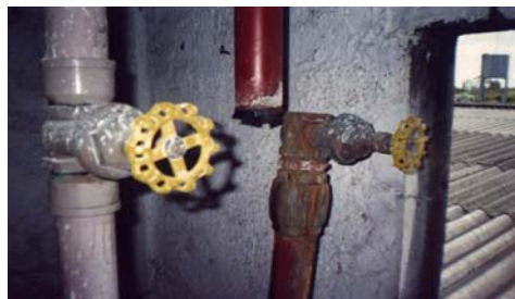
Figura 03 – Tubulação de incêndio rompida entre o alimentador e o registro
