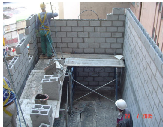
Figura 3 Construção de nova escada de emergência, em área externa ao edifício
