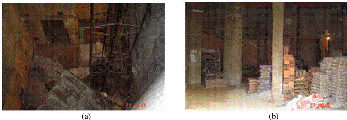
Figura 6 Utilização de elevador para movimentação de mão de obra e materiais no vão central (a) e armazenamento de material no pavimento térreo (b)
