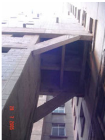
Figura 3 Construção de nova escada de emergência, em área externa ao edifício
