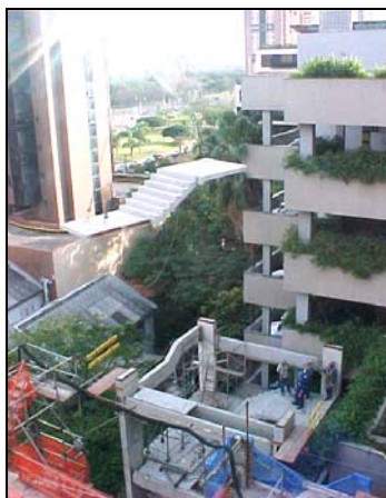
Figura 1 – Posição da escada em relação às edificações vizinhas
