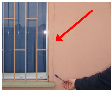
Figura 08: Fissura vertical na parede externa
