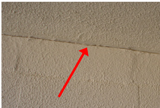
Figura 06: Defeito no apoio da laje do último pavimento (irregularidades e fissuras)
