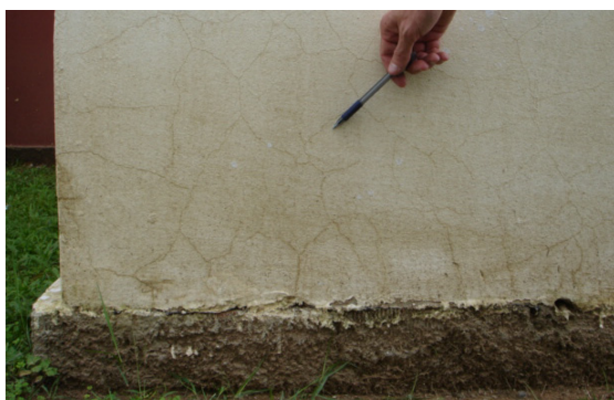
Figura 04: Fissuras mapeadas do revestimento externo
