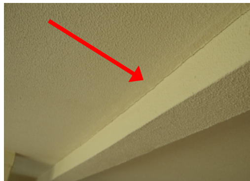
Figura 07: Fissura na união das lajes pré-moldadas da sala e cozinha
