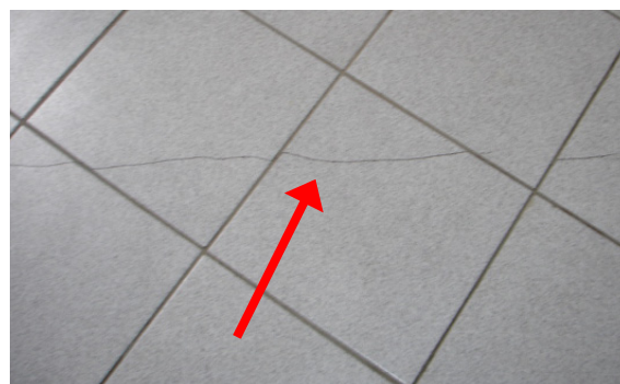
Figura 05: Fissuras na diagonal da laje do dormitório
