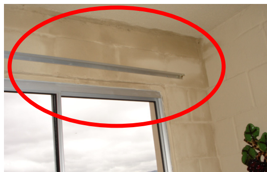
Figura 09: Infiltração nas paredes internas
