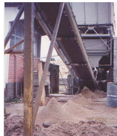
Figura 7: Perda de material na correia transportadora
