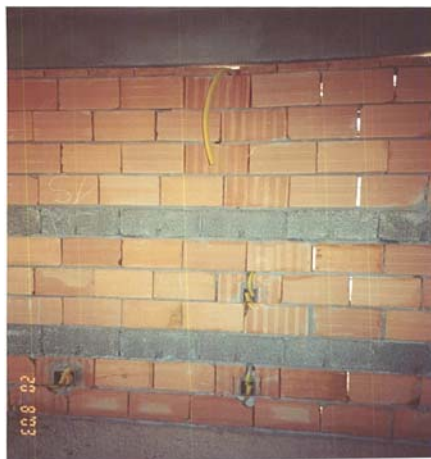
Figura 5-posicionamento de fiadas para fachada ventilada
