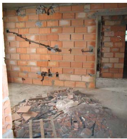
Figura 1-aspectos comuns na alvenaria tradicional: (1) geração de entulhos, (2) corte em alvenaria para embutimento de tubulações e (3) consumo excessivo de argamassa
