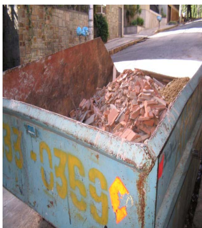
Figura 1-aspectos comuns na alvenaria tradicional: (1) geração de entulhos, (2) corte em alvenaria para embutimento de tubulações e (3) consumo excessivo de argamassa
