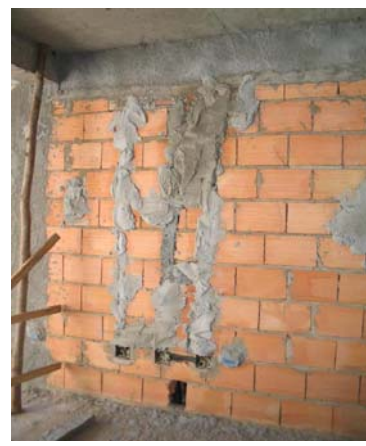
Figura 1-aspectos comuns na alvenaria tradicional: (1) geração de entulhos, (2) corte em alvenaria para embutimento de tubulações e (3) consumo excessivo de argamassa
