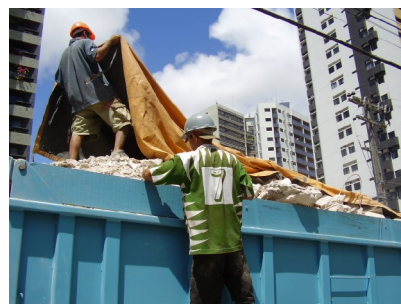
Figura 17 Colocação de lona para proteção
