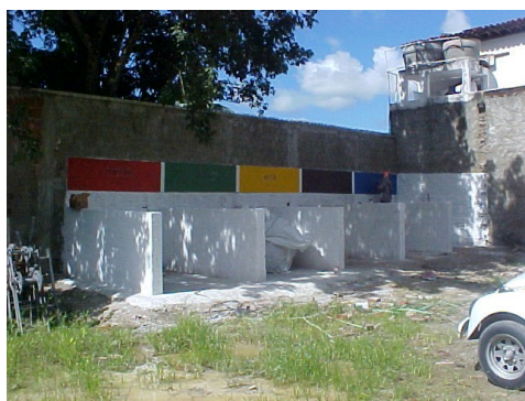
Figura 6 Baías de coleta seletiva em canteiro de obra
