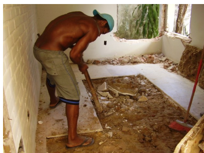
Figura 14 Retirada do piso
