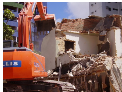
Figura 13 Demolição mecanizada
