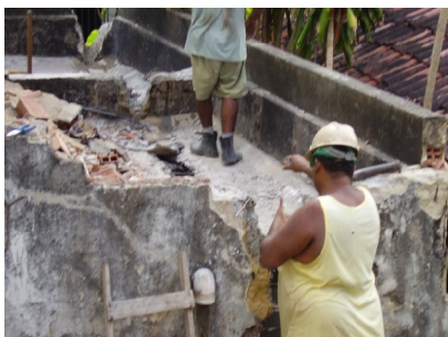
Figura 12 Demolição manual
