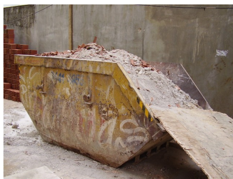
Figura 7 Caçamba estacionária utilizada para deposição da metralha
