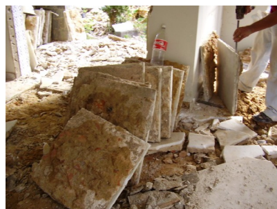
Figura 15 Separação do piso para futuro reaproveitamento
