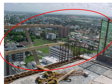
Foto 6 – Periferia da laje sem proteção contra queda, situação de grave e iminente risco.
