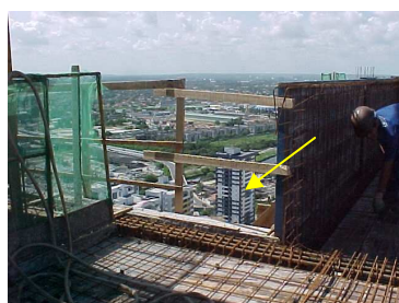
Foto 5 – Proteção de periferia em desacordo com a norma por não apresentar as dimensões estabelecidas por ela.
