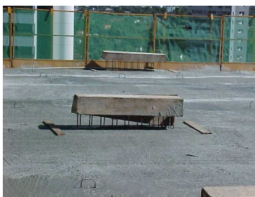
Foto 2 – Pontas verticais de vergalhões devidamente protegidas, logo situação conforme (CO) a NR 18.
