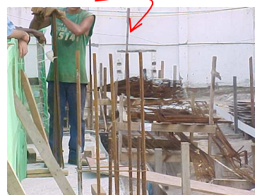
Foto 3 – Pontas verticais de vergalhões desprotegidas. Situação de grave e iminente risco (GIR) de acordo com a NR 18.
