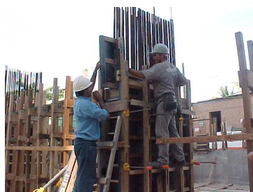
Foto 1 – Pontas verticais de vergalhões acima da área de trabalho, logo não se aplica (NA) a proteção para as mesmas.
