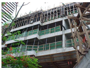
Foto 4 – Vista da obra com proteção de periferia conforme a norma.
