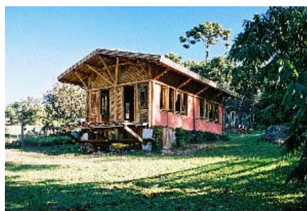
Edificação com estrutura de bambu. Fonte: www.bambubrasileiro.com - 1557 -
