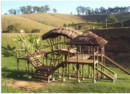
Brinquedo infantil - estrutura de bambu e cobertura com fibra natural; Fonte: www.bambubrasileiro.com
