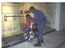
Figuras 3 e 4 – Existência de desnível prejudicando o acesso do cadeirante. Presença de obstáculos na circulação dificultando o deslocamento do usuário deficiente visual.
