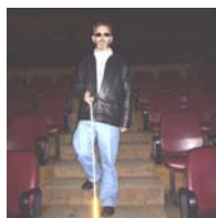
Figuras 1 e 2 – Ausência de sinalização tátil no piso indicando o início e término da escada. Ausência de sinalização visual ao longo das circulações.
