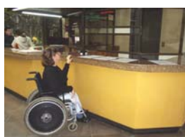
Figuras 5 e 6– Ausência de espaço para aproximação na bilheteria. Telefone Público com manual de uso sem legibilidade dificultando o manuseio da usuária com baixa visão.
