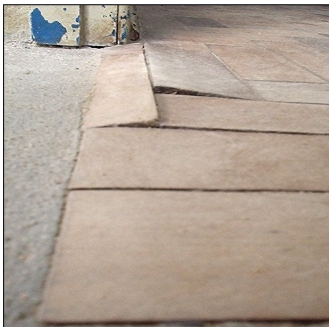
Foto 3 – Desníveis nos tacos por recalque do contra-piso
