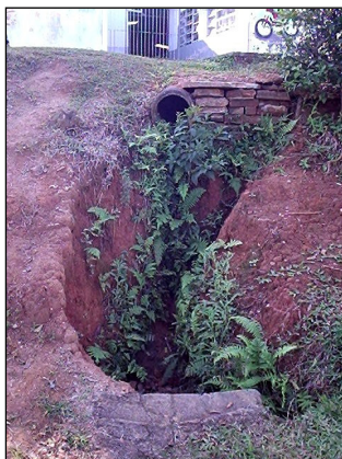
Foto 13 - Erosão em talude
