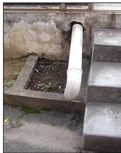
Foto 9 - Água pluvial deságua no pátio
