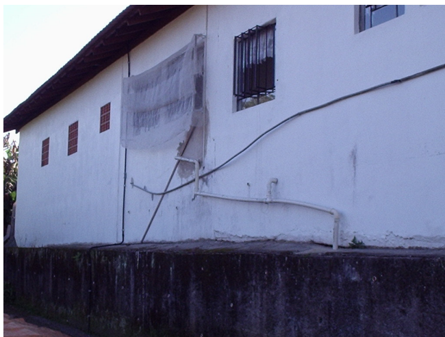
Foto 8 - Tubulações aparentes na parede
