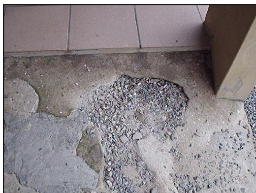
Foto 4 - Piso cimentado desgastado
