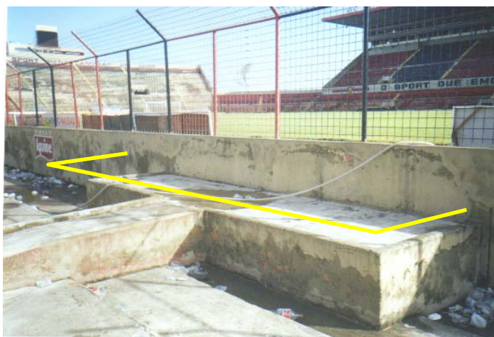
Figura 3 – Assentos Reservados: Ausência de guarda-corpo
