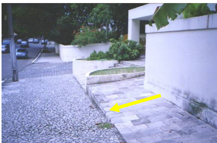
Figura 2 – Rampa com Inclinação Transversal Inadequada
