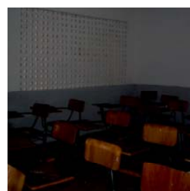
Foto 05 – Sala padrão 02. Detalhes das aberturas tipo cobogós.
