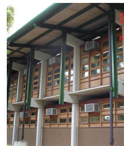
Figura 10: Vedação das aberturas no forro das salas de aula (Arquivo próprio)
