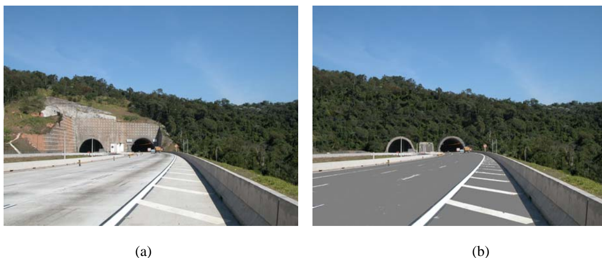
Figura 3 – Emboque Gramado (TE-3). (a) Situação existente. (b) Aplicação das estratégias, alterando a refletância da pista de 30% para 15% (Estratégia 1) e substituindo o entorno do portal (Estratégia 2)
