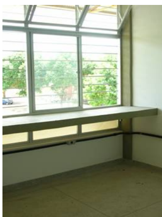
Foto 1 – Peitoril ventilado em edifício de pesquisa da UFAL, Maceió/AL. Fonte: Os autores, 2005.
