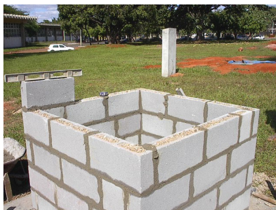
Figura 2: Enchimento dos furos dos blocos de concreto da test-cell com entulho.
