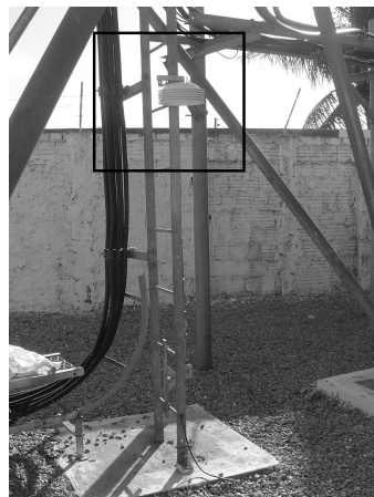
Figuras 04 e 05 – Dois tipos de equipamentos instalados. Uma estação meteorológica e um testor com proteção plástica.
