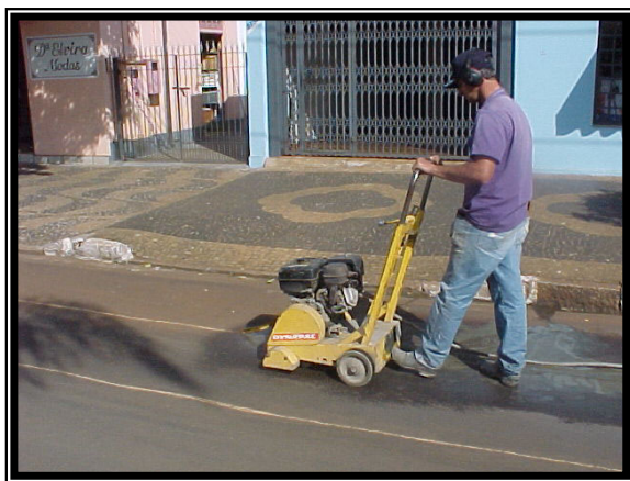
Figura 2 – Indicação da marcação da vala e corte do pavimento asfáltico sendo realizado.
