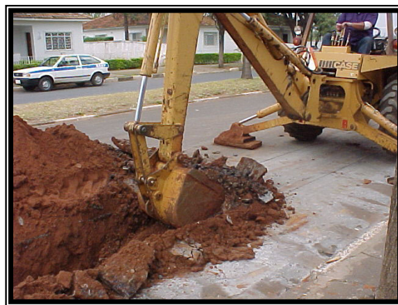
Figura 3 – Abertura da vala com a retro-escavadeira.
