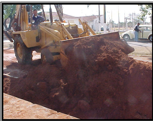
Figura 5 – Reenchimento da vala pela retro.
