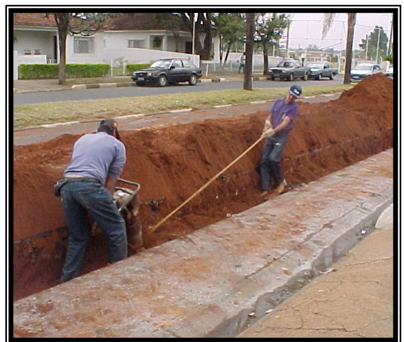
Figura 6 – Compactação mecânica da vala.
