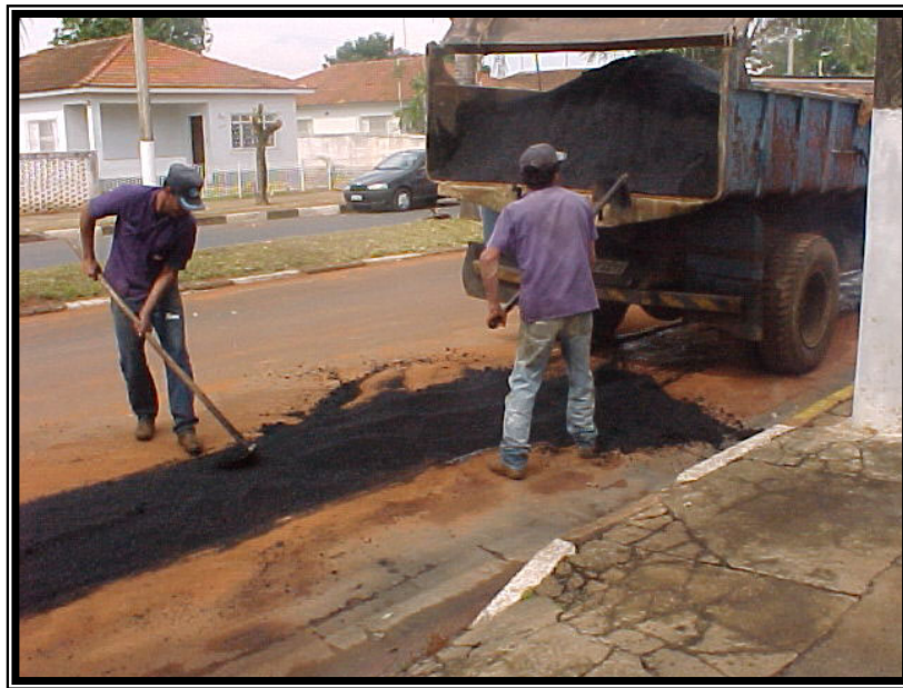
Figura 7 – Reconstituição do pavimento asfáltico (repavimentação).
