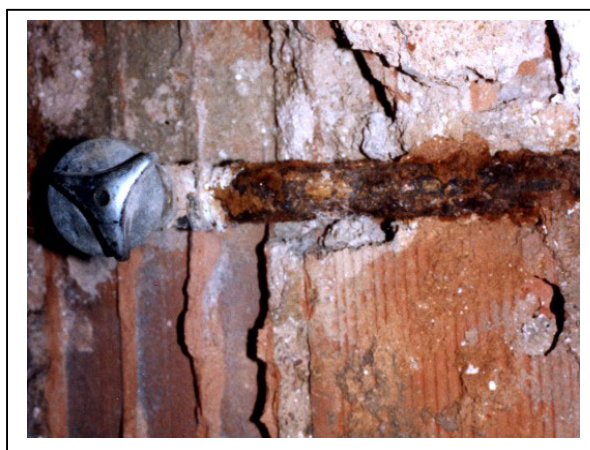
Fig. 9 – Corrosão externa de tubos galvanizados
