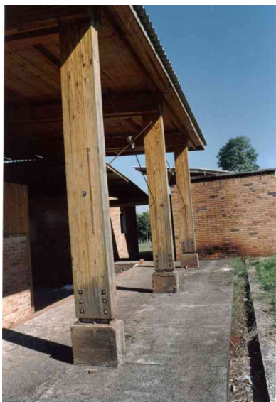
Figura 5: Ação das intempéries sobre os elementos da estrutura
