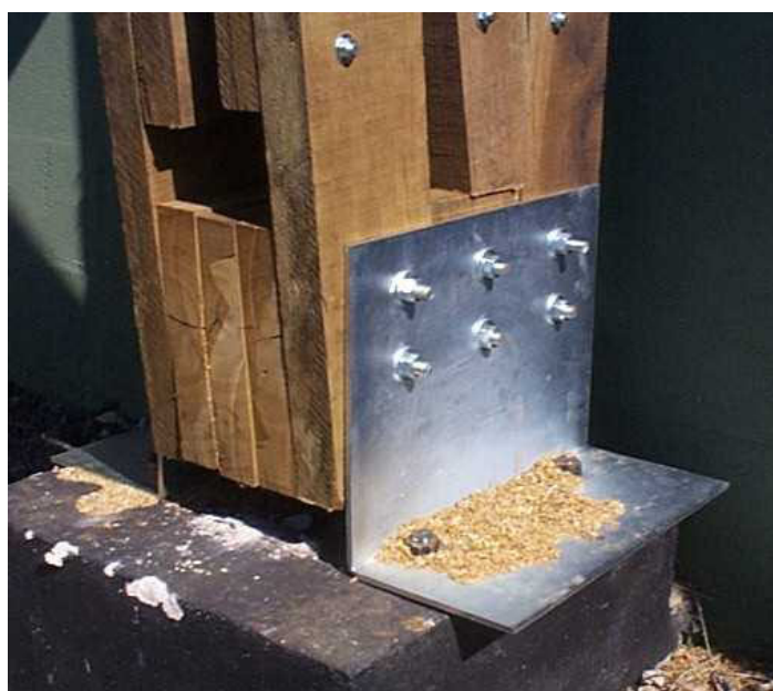
Figura 08: Sistema de ligação pórtico – chapa metálica
