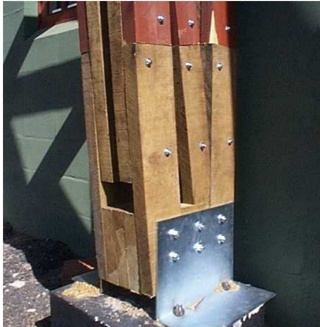
Figura 09: Cobrejuntas de ligação
