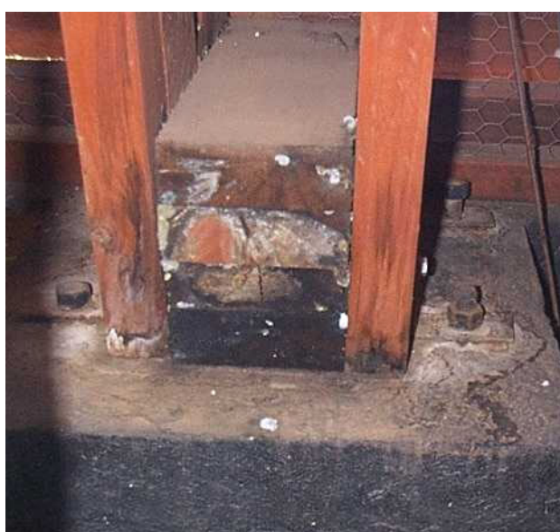
Figura 05: Pilares de madeira degradados
