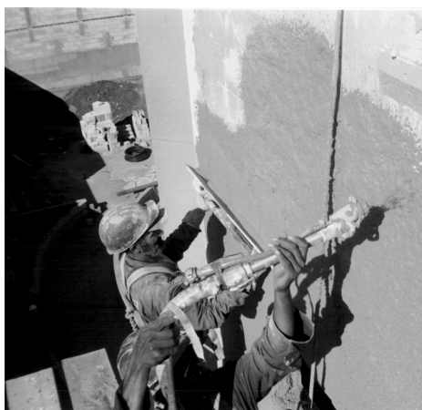
Figura 3 – Aplicação da argamassa por projeção
