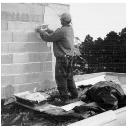
Figura 4 – Aplicação manual da argamassa com desempenadeira
