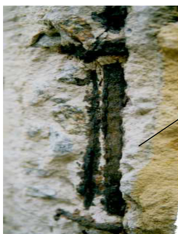
Figura 2 - Corrosão e baixos cobrimentos da armadura.
