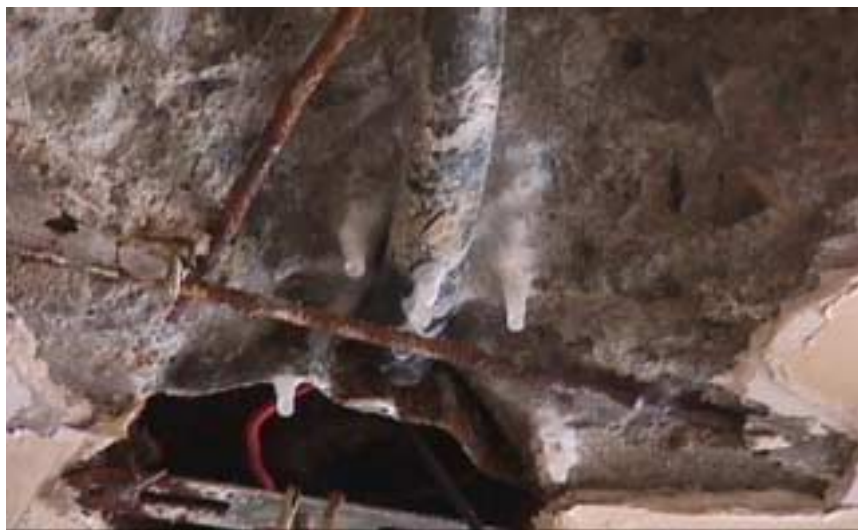
Fotografia 3.2 – Infiltração no ponto de luz na laje térrea
