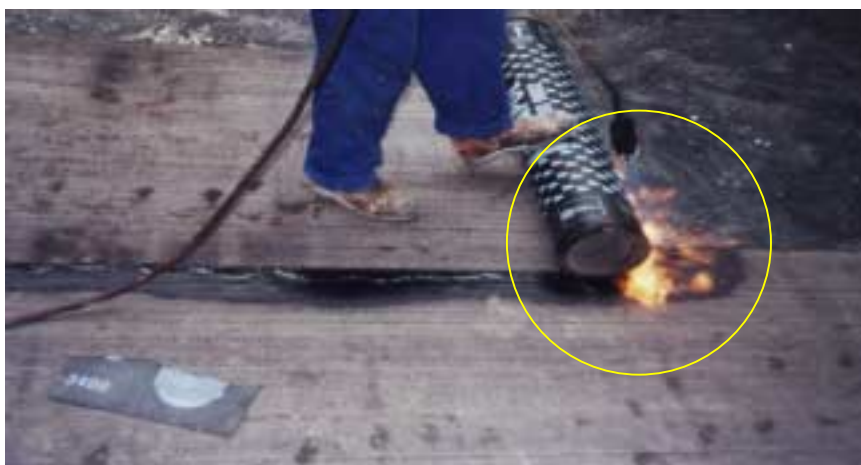
Fotografia 3.1 – Uso do maçarico em mantas asfálticas
