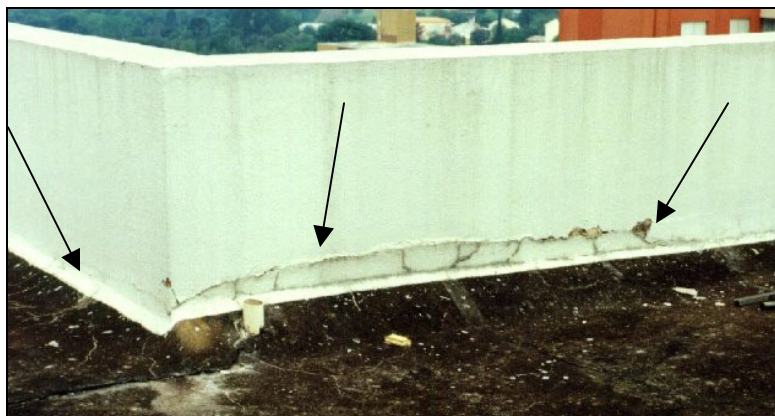
FIGURA 6 - Fissuras de conformação variada nas platibandas e marquises
