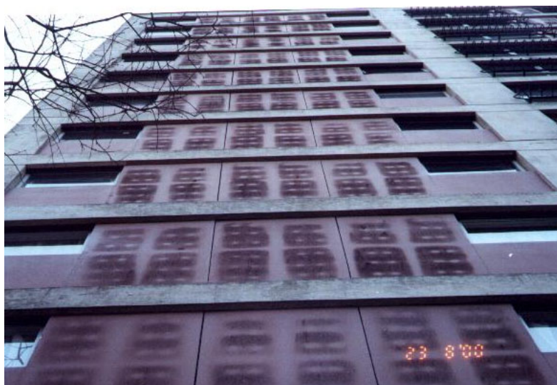
Figura 1 – Fachada do edifício com problemas de desenvolvimento de microrganismos
