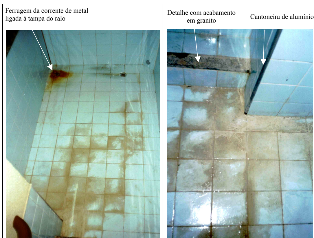
Figura 4 – Aspecto geral da eflorescência
