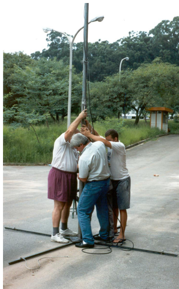
Fig. 11 – Montagem do poste suporte dos painéis solares.
