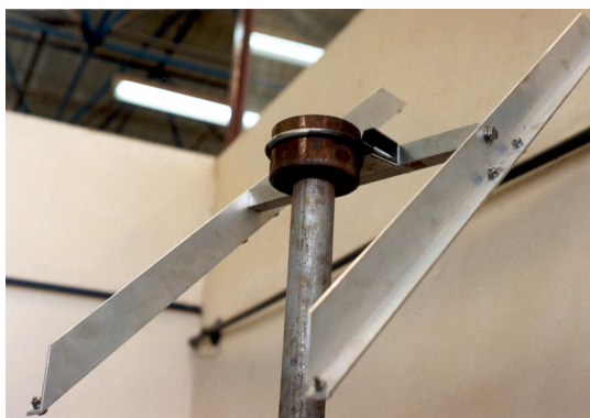
Fig. 08 – Haste final com o suporte adquirido na Heliodinâmica para encaixe dos painéis fotovoltaicos.
