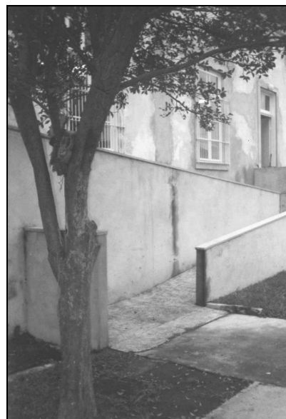
Figura 5: Instituição E1 – rampa de acesso ao pátio
